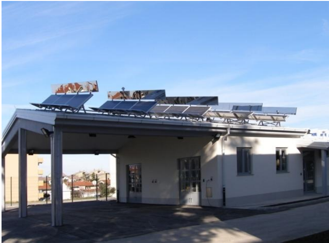
Slika 12: Sledilno zrcalni tip sončne elektrarne
