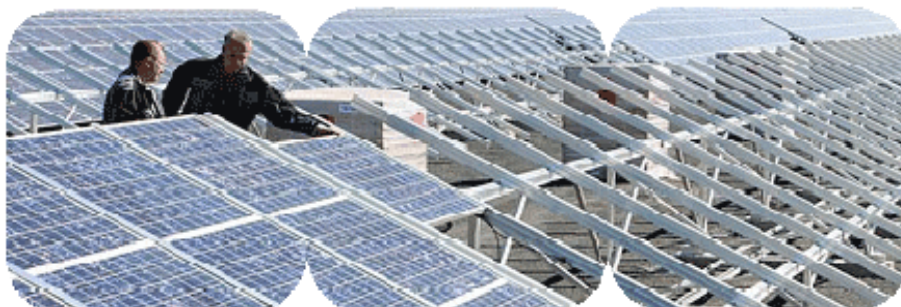
Slika 7: Aluminijasta podkonstrukcija
