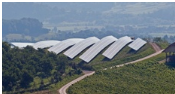
Slika 5: Buče – prostostoječa elektrarna z močjo 530 kW
