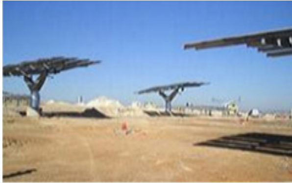
Slika 1: Španija - polje solarnih sledilnikov z močjo 700 kW
