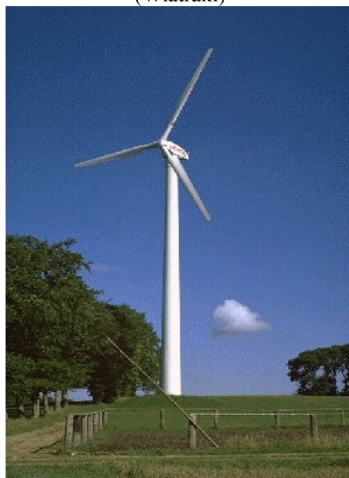
Horizontalna turbina vzgonskega tipa. Rotor premika po smeri vetra servomotor. (Nordex) * (tabeli in slike so vzeti iz članka Damjana Božiča)
