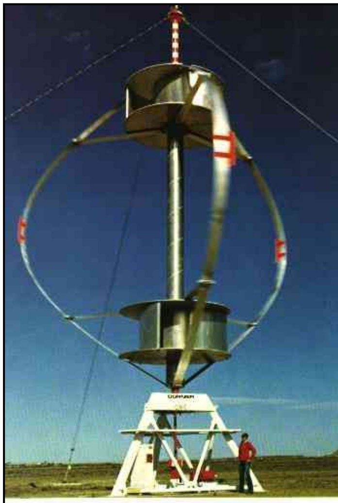
Vertikalna Darreiusova turbina. Prigrajena sta dva uporabna Savoniusova rotorja, ki omogočata zagon. Lopatice so oblikovane po posebni krivulji, kar omogoča da v lopatici ni upogibnega napetostnega stanja. Veter lahko piha iz katerekoli smeri. (Wiatraki)
